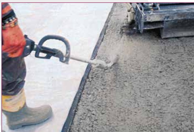
VIBRATURA GIUNTO DI COSTRUZIONE
